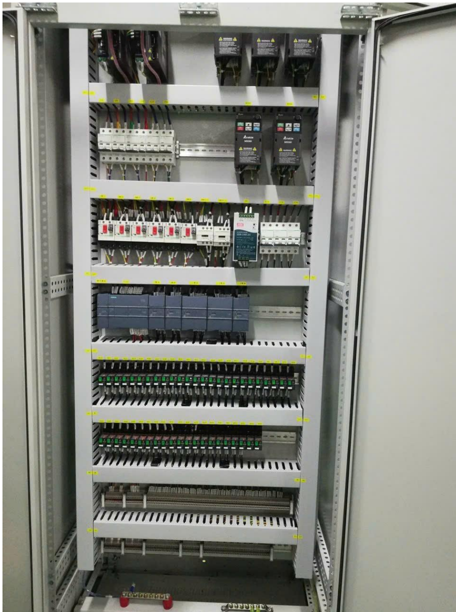
Hình 25: Kết cấu tủ điện công nghiệp
