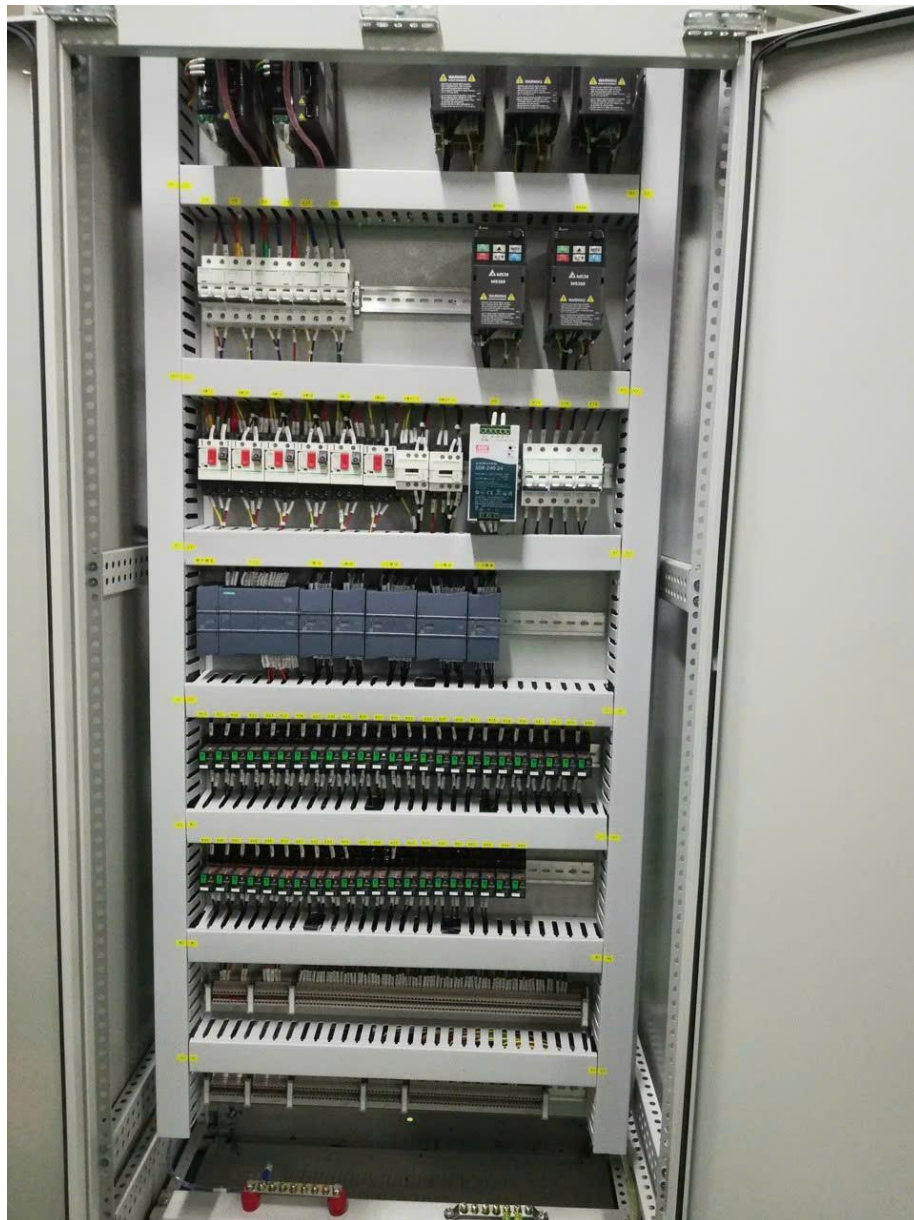
Hình 28: Kết cấu tủ điện công nghiệp
