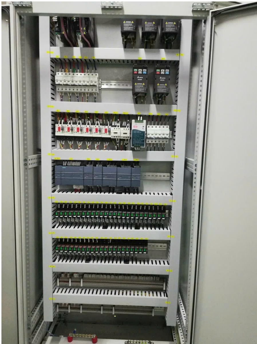
Hình 31: Kết cấu tủ điện công nghiệp
