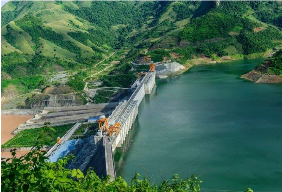
Hình 1.34: Nhà máy thủy điện
