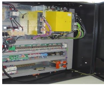
Lắp tủ điện máy CNC
