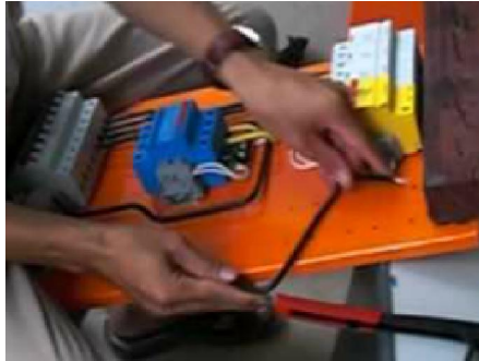
Hình 1.14: Đo dây khi lắp dây vào bảng mạch.
