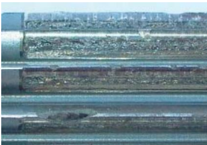
Hình 29: Bộ truyền bánh răng côn bị tróc rỗ bề mặt
