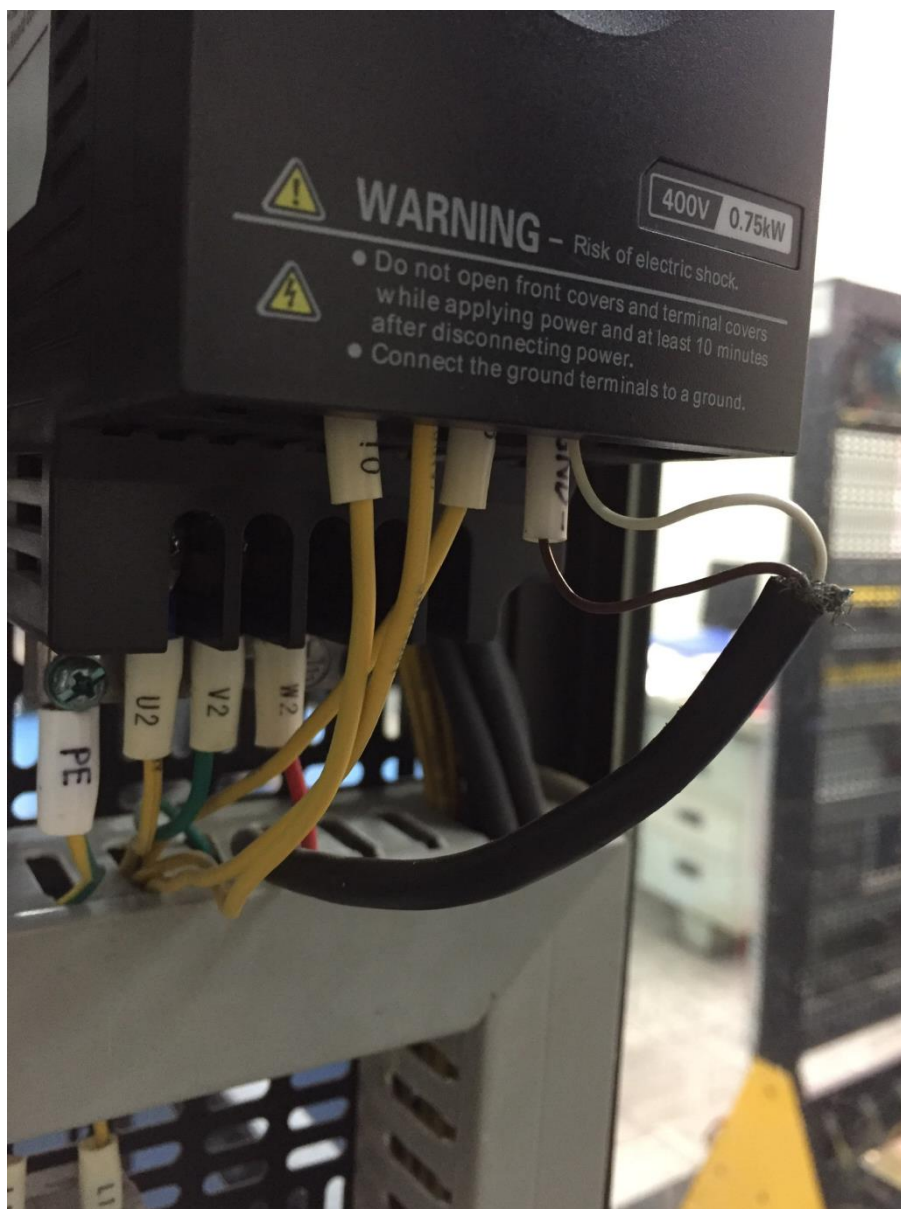
Hình 52: Đầu nối động lực biến tần
