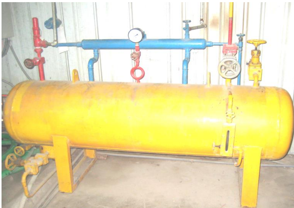
Hình. 2.27. Bình chứa cao áp
